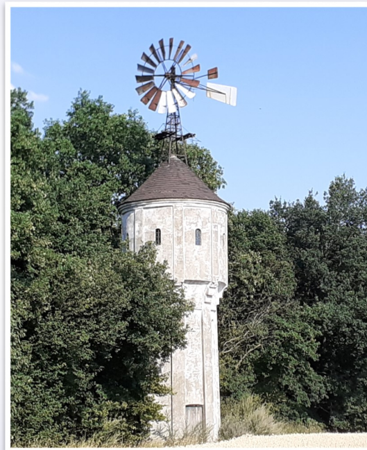
Wasserturm mit Pumpenwindrad bei Schönthal
